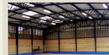
**Boulodrome** : Traitement de la charpente contre la rouille et réfection des peintures. Rénovation de la peinture de l'ossature. Montant TTC : 19 134,60€ et du bardage en bois. Montant TTC : 3 682,20€.
